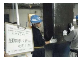
炭素繊維による柱 の補強
