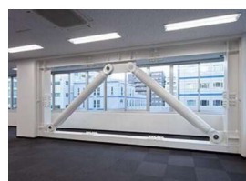
接着ブレース工法
